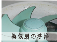
換気扇の洗浄
