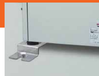
アジャスト用耐震金具取付の一例
