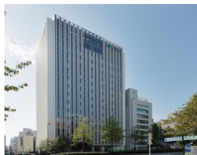
愛知県信用農業協同組合連合会 JAあいちビル
