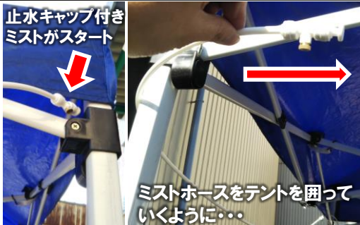
最後はホースとテント生地を自在クリップで挟むだけ
