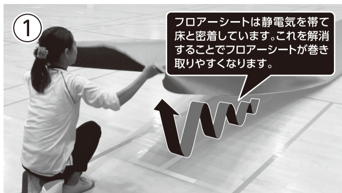
最初にフロアシートを上下に大きく動かして床とフロアシートに間に空気を入れます。
