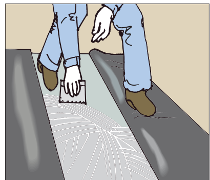
●ビニル床シートの施工に
