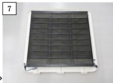
本体フィルターを取付固定
