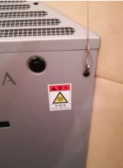
転倒防止ワイヤー取り付け例
