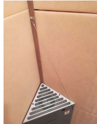
転倒防止ワイヤー取り付け例
