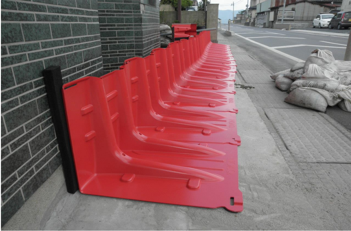
シーリングストリップ材 (ボックスウォールと壁の間に挟み込んで設置)
