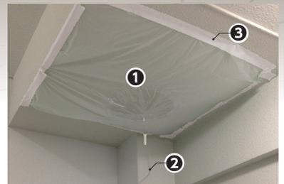
水漏れ箇所に合わせて【①専用シート】を【③専用テープ】で貼りつけ【②専用ホース】をセットします。
