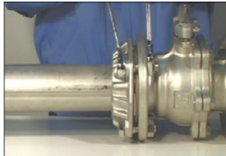
⑧ JIS10KフランジとF式フランジにテフロン包みガスケットを挿入しボルトを締め込みする。フランジガスケットは金属フランジ用を使用して下さい。
