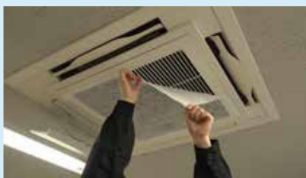
天井エアコンへの A600 取付例
