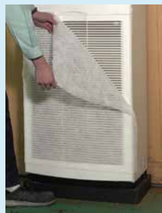
工場エアコンへの A800 取付例
