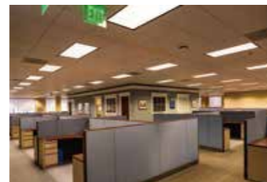
オフィスなど室内照明の管理
