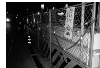
●工事現場など
