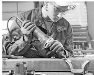
溶接ビードの表面処理作業に!
