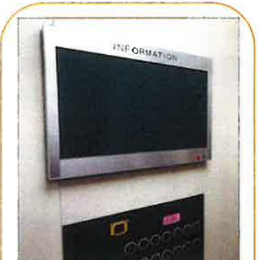
防炎掲示板 EV内設置事例
