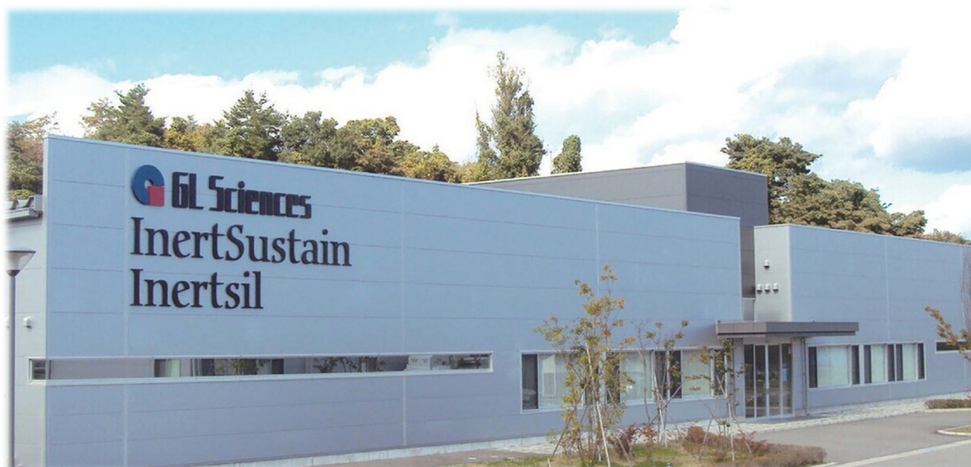
世界最大級のHPLCカラム製造工場を2019年に日本国内に新設
