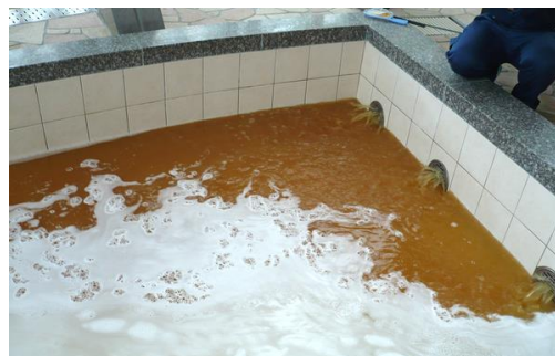
循環配管内のスケール除去作業の様子
