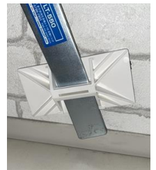
③剥離工具を差し込み、水平に回転
